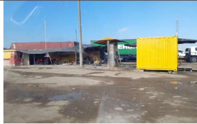
Foto No. 2. Estación de servicio en desuso
