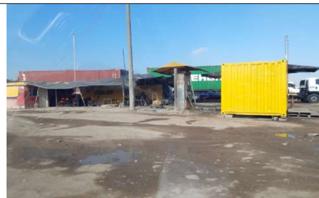
Foto No. 2. Estación de servicio en desuso
