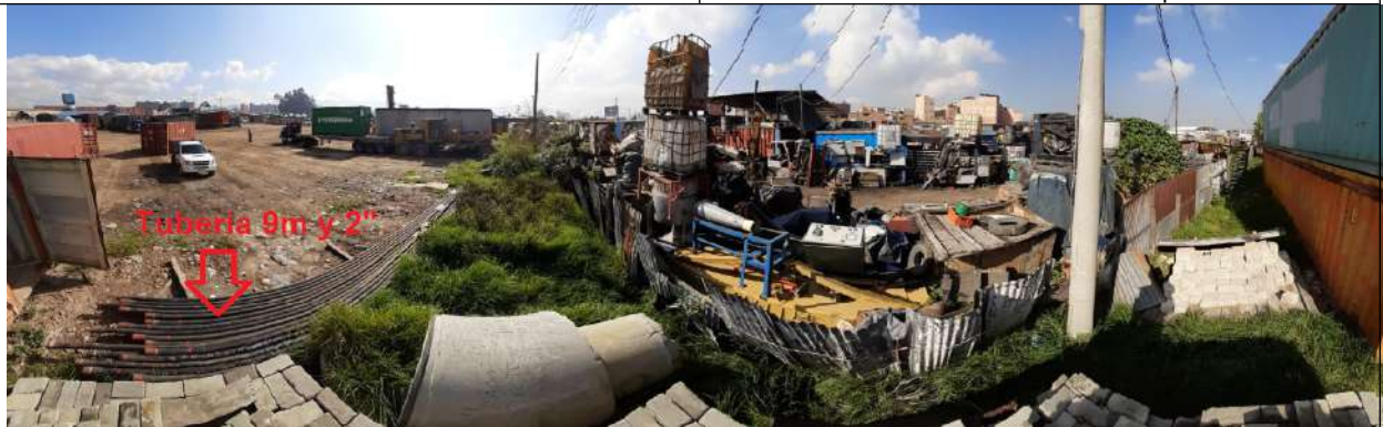
Foto No. 5. Panorámica antigua zona de lavado, tubería de almacenada, almacenamiento de material sin clasificar.
